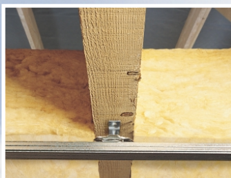
2 Mise en place de l'ossature métallique** et réglage de la planéité
