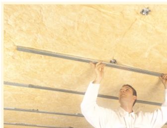
4 Mise en place de l'ossature métallique** et réglage de la planéité
