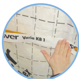
Adhésif Vario KB1 pour l'étanchéité au jointolement des lés de la membrane
