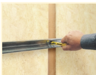
2 Implantation des lisses Clip'Optima, de la fourrure Optima et des appuis Optima**
