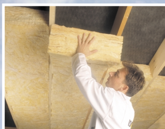
1 Mise en place de l'isolant Isoconfort entre les fermettes
