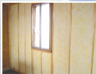
1 Mise en place de l'isolant Isoconfort «MOB» entre montants
