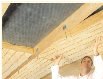
2 Mise en place la 1 ère couche d'isolant Isoconfort entre chevrons
