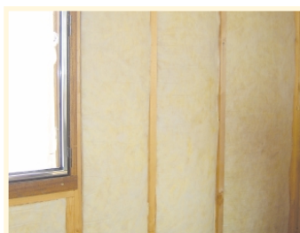
1 Mise en place la 1 ère couche d'isolant Isoconfort «MOB» entre montants
