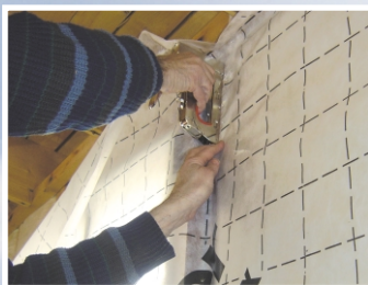
2 Pose de la membrane climatique Vario Duplex et de ses accessoires* sur montants
