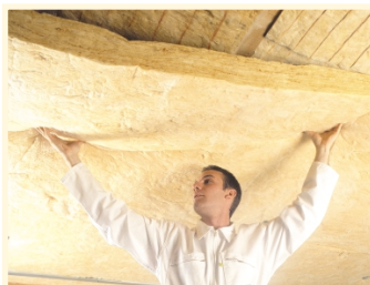
3 Mise en place la 2 ème couche d'isolant Isoconfort sous chevrons
