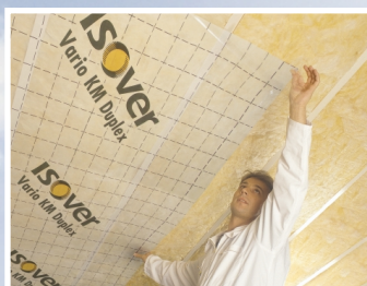
2 Pose de la membrane climatique Vario Duplex et de ses accessoires*
