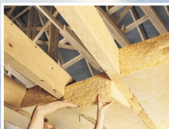
1 Mise en place de l'isolant Isoconfort «MOB» entre les solives ou fermettes
