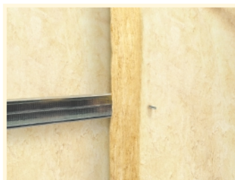
3 Mise en place la 2 ème couche d'isolant Isoconfort «MOB» devant montants
