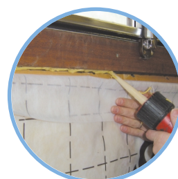
Mastic Vario DS pour l'étanchéité à la périphérie
