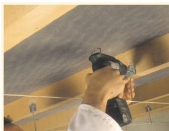
1 Fixation des suspentes Intégra
